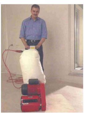
1. Coloque a máquina de afagar de rolo na divisão e posicione-a no sentido correcto.
